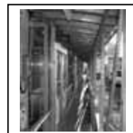
写真 17: 仮設住宅 (各室前の屋根付通路部分)
