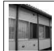
写真 12: 一般棟外壁面換気孔とサッシ
