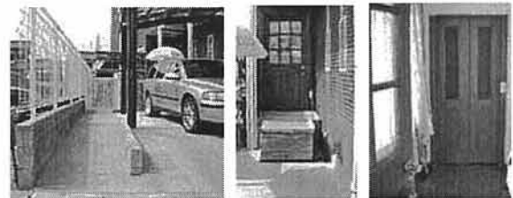
①スロープ ②リフト ③ホームEV
