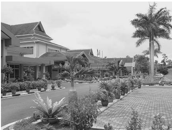
バンギ・センター正面入口
