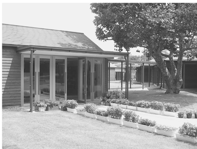
写真1 各務原養護学校の新校舎
