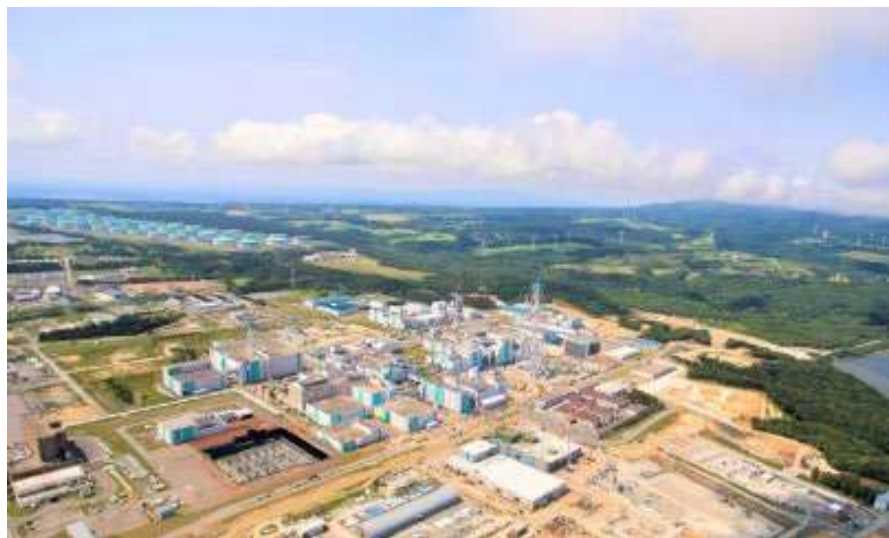
六ヶ所再処理工場
