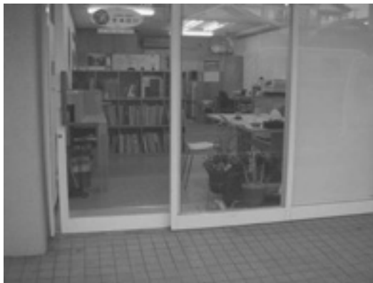
事務所玄関先のバリアフリー改修
