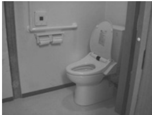
トイレを広めに改修
