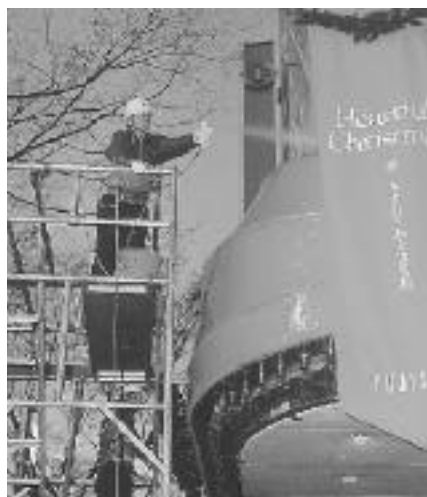
高圧洗浄作業
