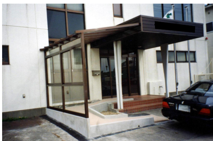
図4 スロープに雨天対策の屋根と風雪対策の風よけを設置
